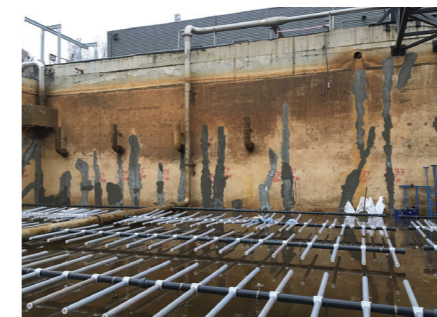
Герметизация железобетонного азотанка на «Московской Пивоваренной Компании»
