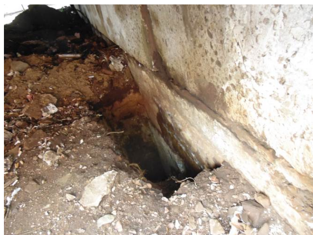
Фото 8. Фото 9. Проходки шурфов № 2 и № 3.
