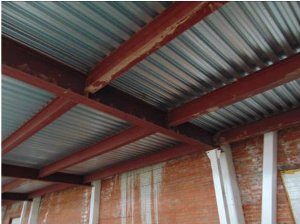
Фото 174. Мезонин (антресоль) вдоль оси 4 в осях У-Ж. Главные и второстепенные балки перекрытия мезонина.
