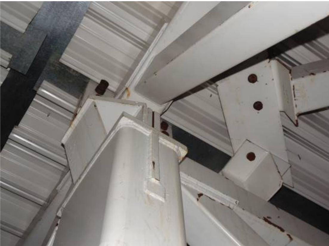
Фото 99. Верхний оголовок колонны. Узел опирания ферм на колонну.
