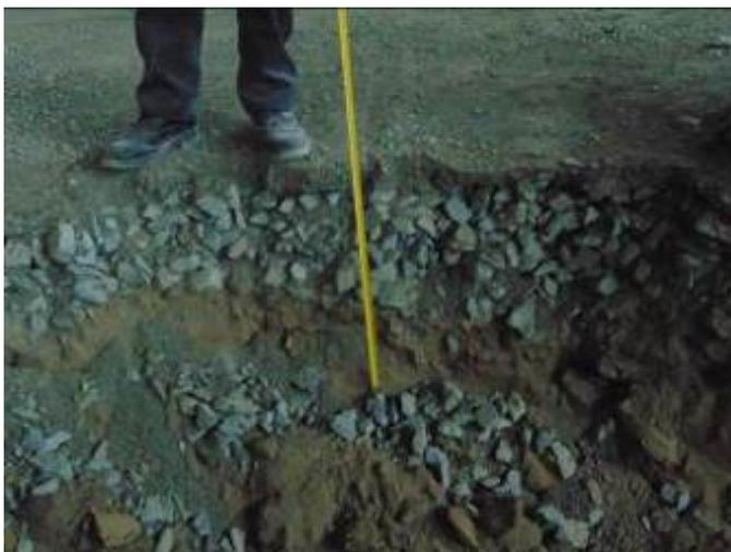
Фото 226. Толщина основания из смеси песка с щебнем не менее 300мм.
