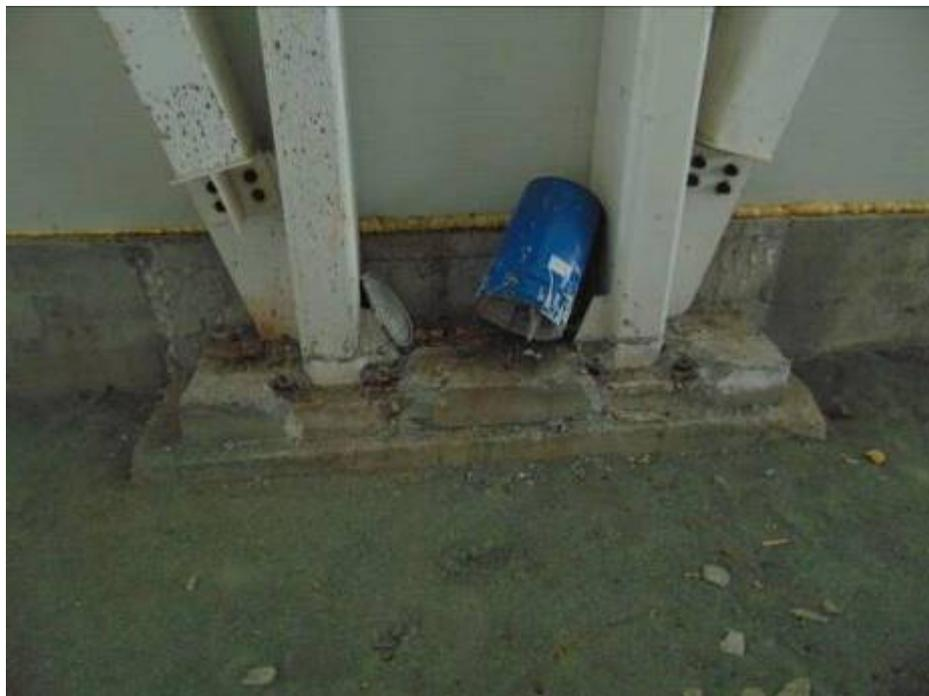
Фото 93. Узел опирания колонны на фундамент на участке температурного шва.
