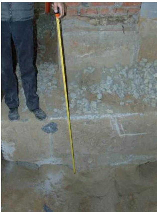
Фото 24. Шурф 3. Железобетонный монолитный ростверк.
