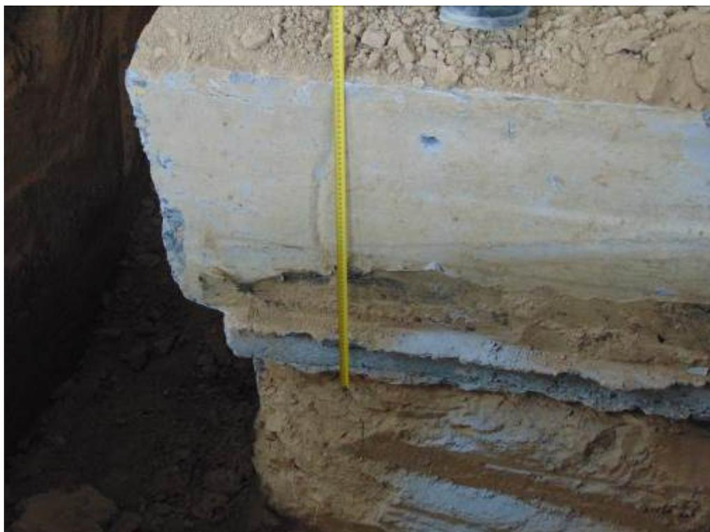
Фото 28. Шурф 5. Монолитный железобетонный ростверк.
