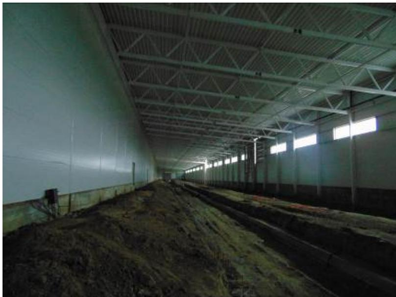
Фото 244. В здании осях 1 – 01/Г-Ю выполнена обратная засыпка грунта.
