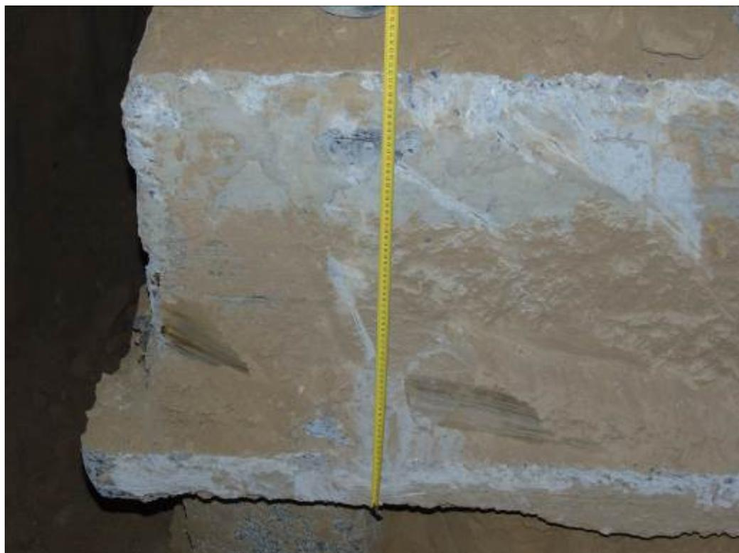
Фото 32. Шурф 6. Плитная часть железобетонного ростверка.
