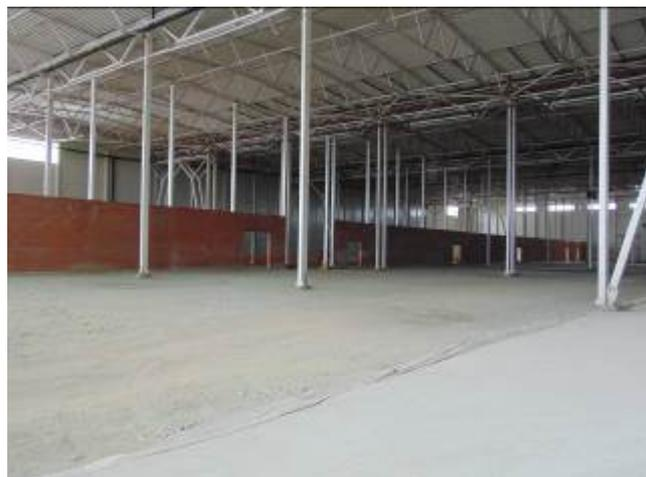
Фото 243. Бетонная подготовка по оси Е.
