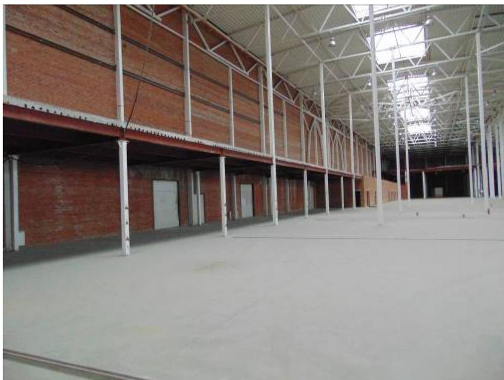
Фото 177. Металлокоркас мезонина опирается на металлические колонны из гнутого замкнутого профиля.
