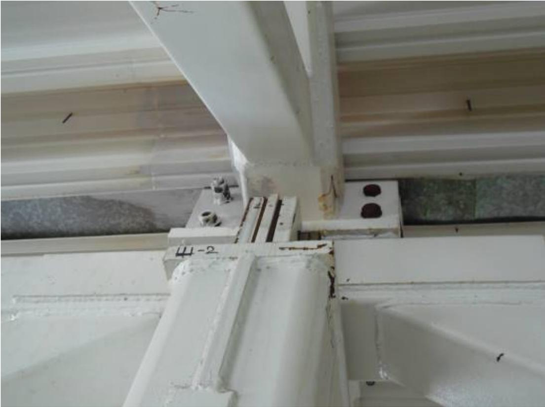
Фото 98. Верхний оголовок колонны. Узел опирания ферм на колонну.
