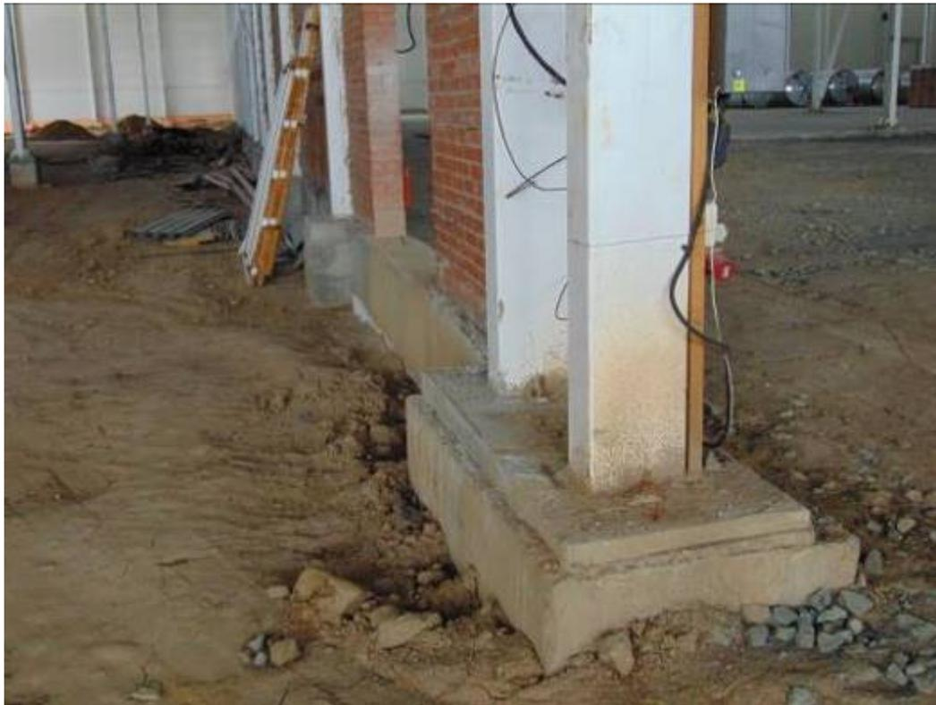
Фото 96. Опираие колонн на фундамент на участке температурного шва.
