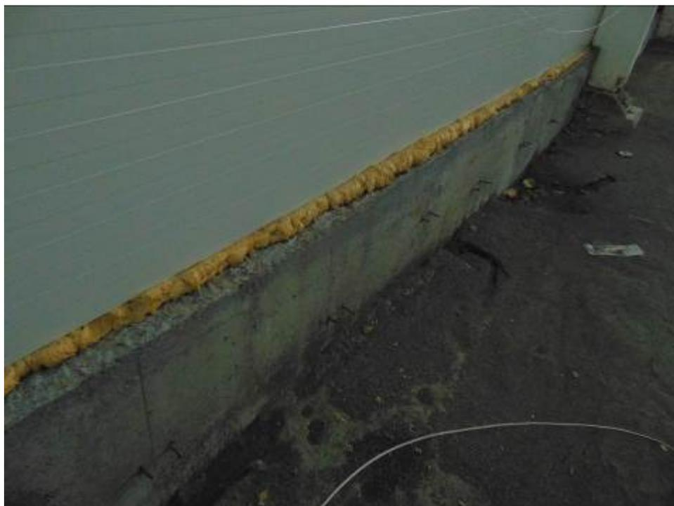
Фото 41. Фрагмент железобетонной монолитной цокольной стены по оси 1.
