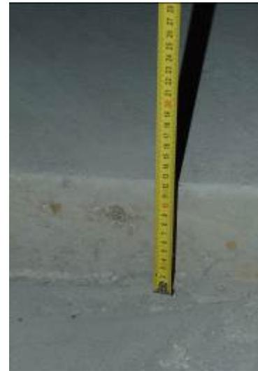
Фото 228, 229. Толщина бетонной подготовки под полы 110-130мм.
