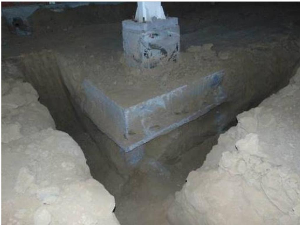
Фото 33. Шурф 6. Монолитный железобетонный ростверк. Под ростверком видны забивные железобетонные сваи.
