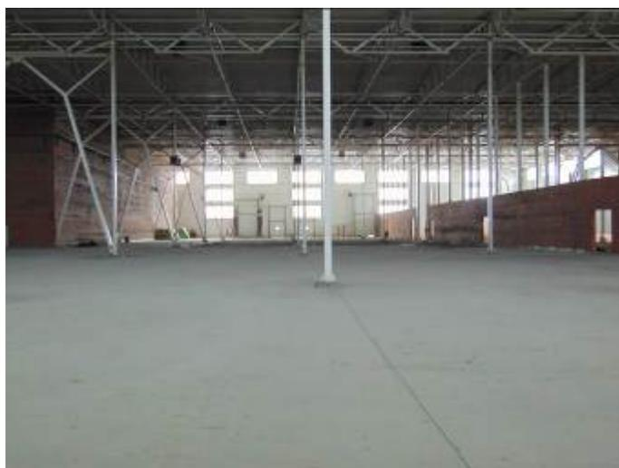
Фото 241. Технологический шов в бетонной подготовке пола по оси Д.
