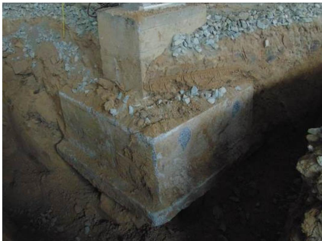
Фото 22. Шурф 2. Общий вид железобетонного монолитного ростверка.
