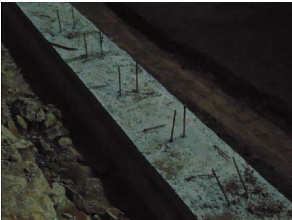
Фото 54. Фрагмент фундамента в помещении в осях 01-1/А-Ю. Видны арматурные выпуски под железобетонные монолитные подпорные стены.
