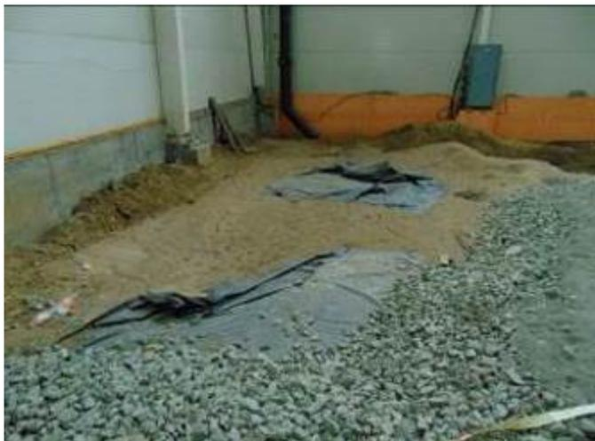
Фото 225. Часть помещения в углу в осях 1/Ю. Под основанием из смеси песка с щебнем видна песчаная подготовка.
