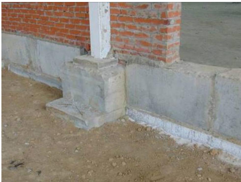
Фото 44. Подколонная часть железобетонного монолитного фундамента под колонну фахверка вдоль осей Г-В между осями 6-7.
