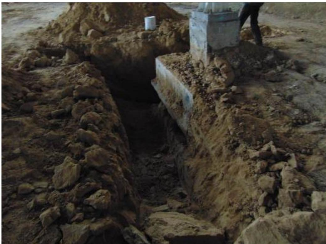
Фото 31. Шурф 6. Монолитный железобетонный ростверк. Под ростверком видны забивные железобетонные сваи.
