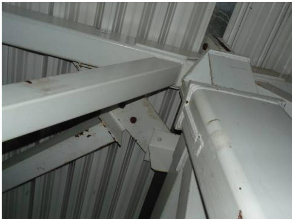
Фото 100. Верхний оголовок колонны. Узел опирания ферм на колонну.
