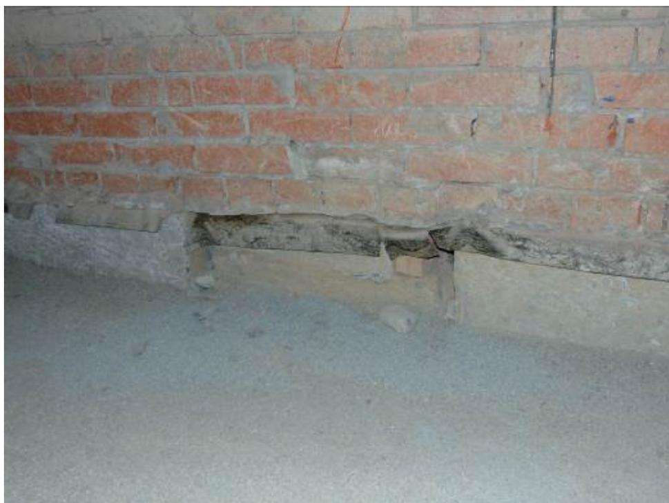
Фото 52. Выполнена горизонтальная гидроизоляция из рулонного гидроизоляционного материала (гидростеклоизол).
