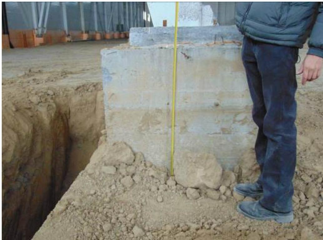
Фото 29. Шурф 5. Подколонная часть монолитного железобетонного ростверка.
