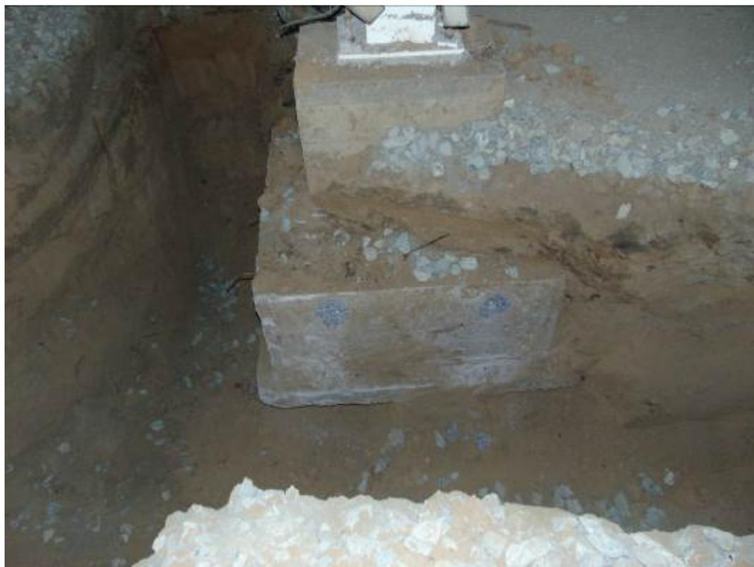
Фото 21. Шурф 2. Общий вид железобетонного монолитного ростверка.
