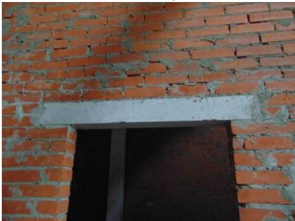
Фото 214. Железобетонная перемычка над дверным проемом в перегородке.
