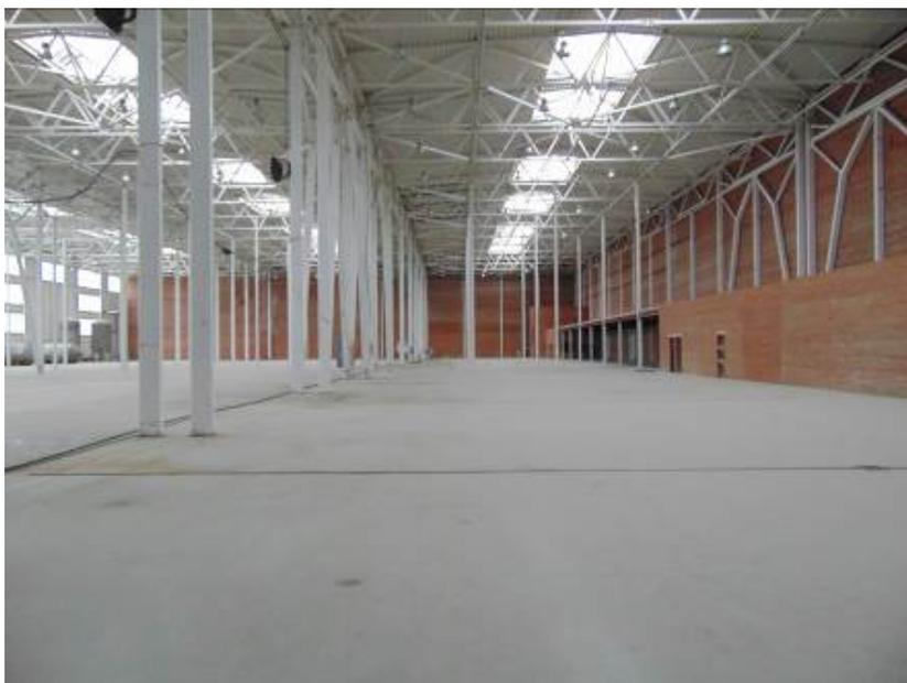
Фото 267. Зенитные фонари в осях Ж-Ц/4-8.
