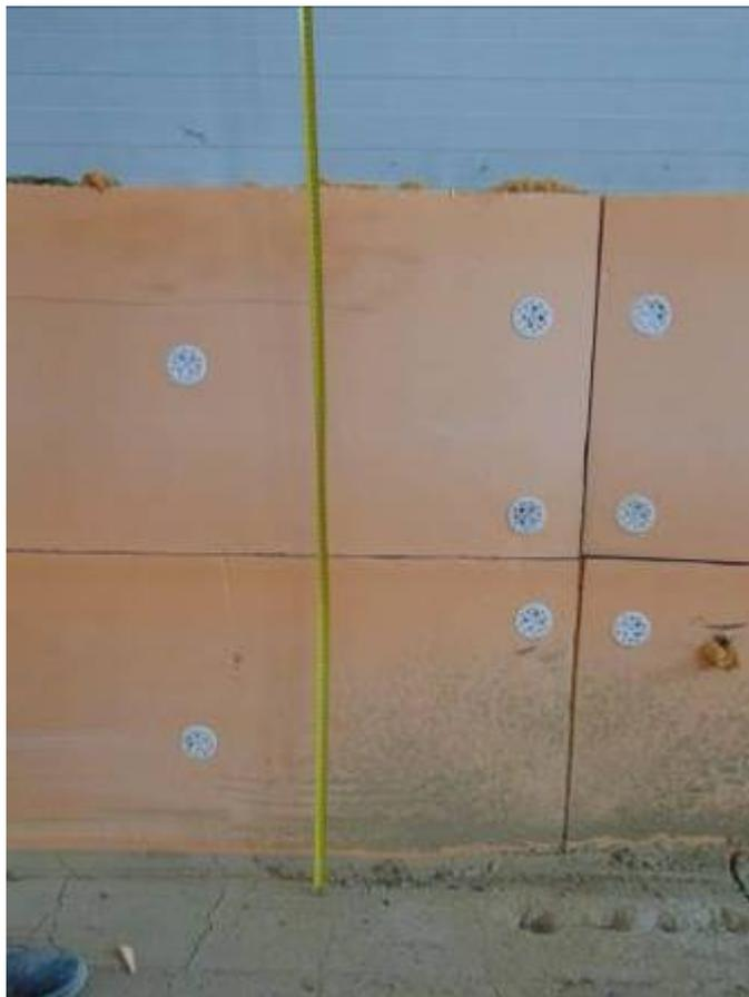
Фото 45. Цокольная стена утеплена экструдированным пенополистеролом.
